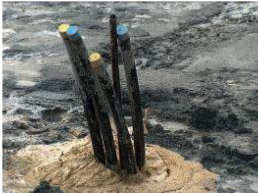
vrt V1 zatěsněn bentonitocementovou injektáží
