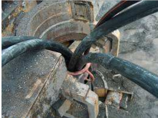
zapouštění GVS do vrtu
