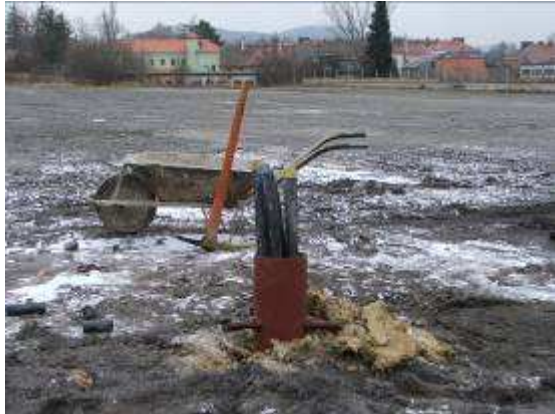
převlečení chráničky pro zajištění vrtu
