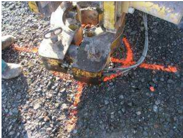
ustavení vrtné soupravy na pozici
