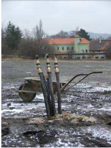
provedení tlakové zkoušky dle norem Gerotherm
