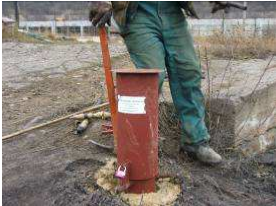
opatření vrtu uzamykatelným uzávěrem
