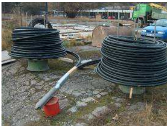
příprava GVS na zapuštění
