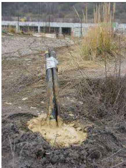
vrt V2 zatěsněn bentonitocementovou injektáží
